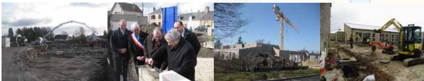
Décembre 2011 : Le chantier est lancé
