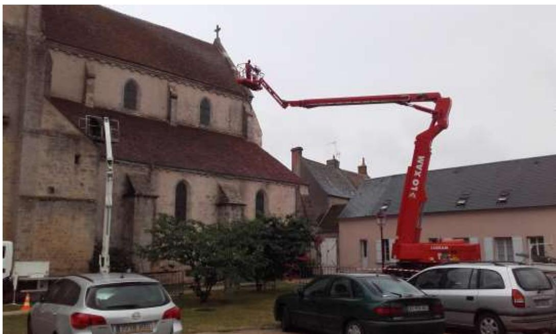
L'Entreprise RICHARD a procédé au démoussage du versant Nord de la toiture de l'Eglise, avec un traitement anti mousse, ainsi qu'au remplacement de tuiles abimées. Une seconde phase sera à programmer dans les années à venir
